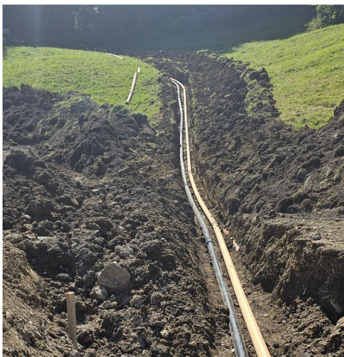
Illustration 2 : lors du creusement des tranchées, la végétation doit être déplacée soigneusement par blocs, puis remise en place. Le sol et ses différentes couches doivent également être reconstitués conformément à leur état originel (photo : Kellerhals + Häfeli AG).
