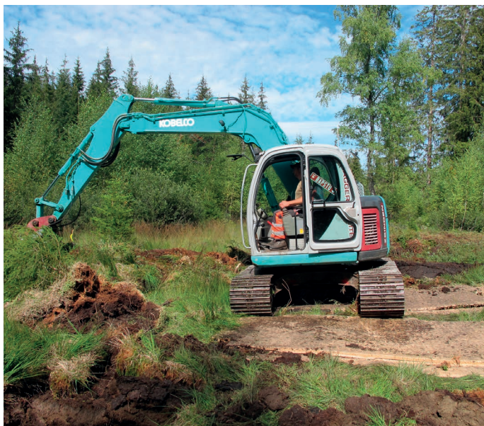
Afin de ménager le sol, des machines légères et des plaques pelles ont été utilisées (Wissenbach, Rüschegg, © Landplan AG).
