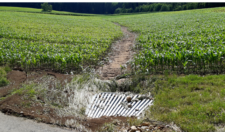
[Figure 3] Erosion de fossé en situation de cuvette – l'eau et le sol érodé s'écoulent au puits à travers la cuvette.
