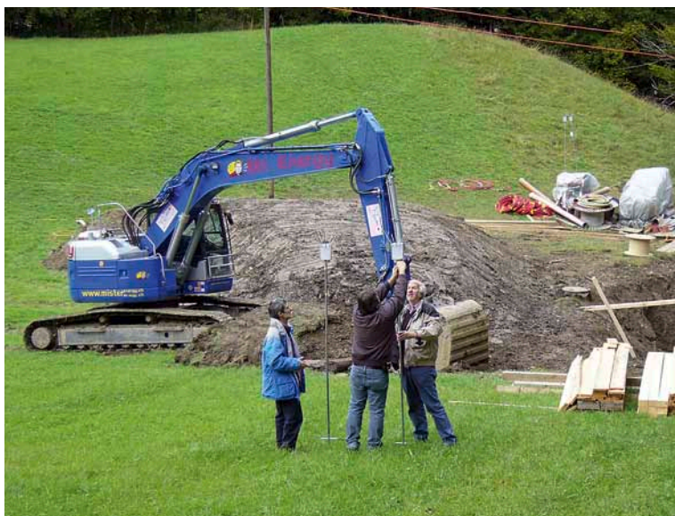
Spécialiste du sol inspectant un chantier
