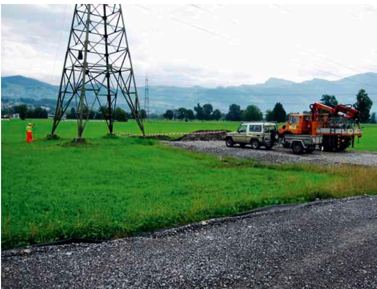
Piste créée pour rejoindre un pylône
