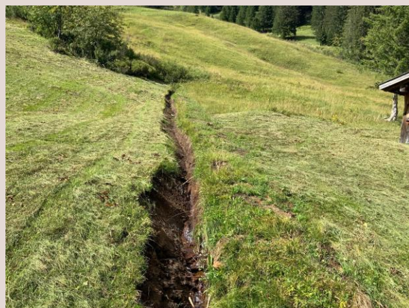
Reprofilage manuel correct du fossé en forme de V
