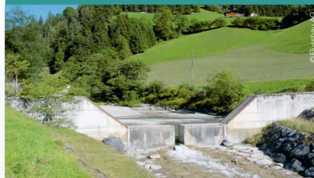
Pièges à gravier perméables
