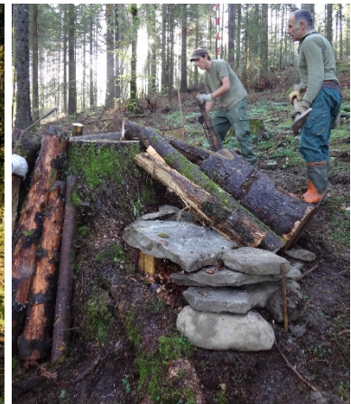
Bau einer Aufzuchtammer
