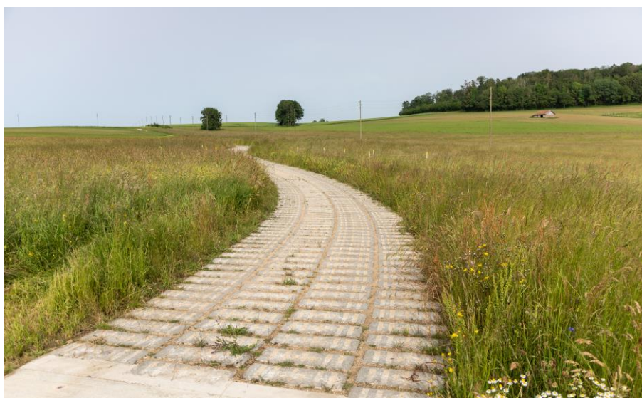
Abbildung 6: Sickerfähige Strasse mit Betonelementen (Foto: LIN'eco)
