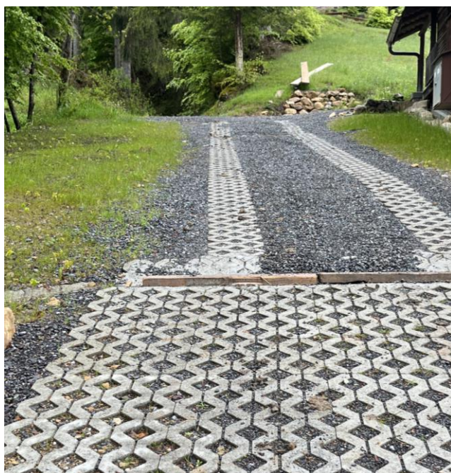
Abbildung 2: Werden Oberflächen durchlässig gestaltet, kann das Wasser diffus versickern.
