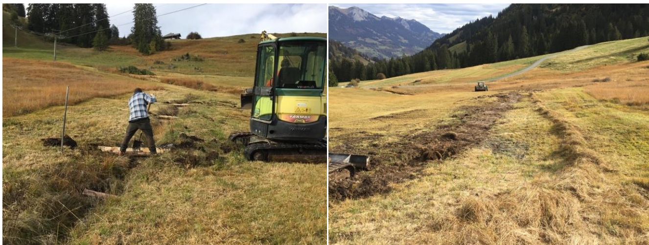
Schliessung eines Entwässerungsgrabens mit Holzspundwänden und Grabenverfüllung
