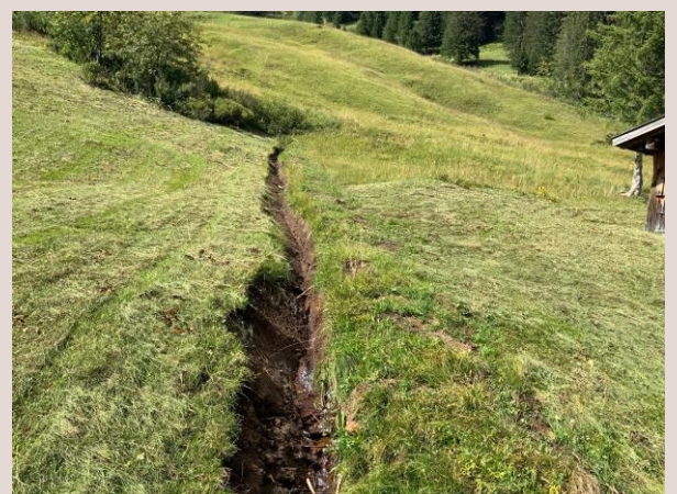
Sachgerecht mit Spaten, V-förmig nachgezogener Graben
