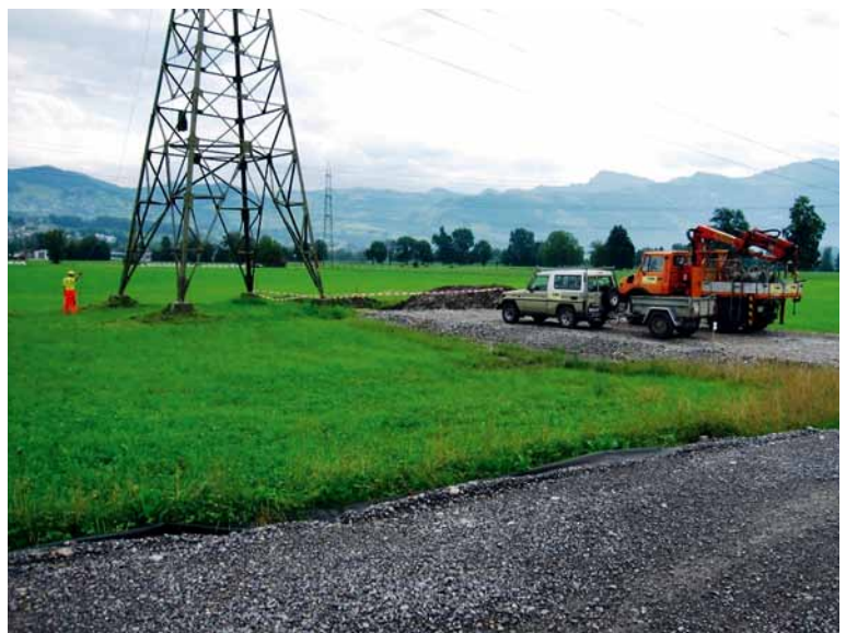
Zufahrt zu Maststandort mit Piste.
