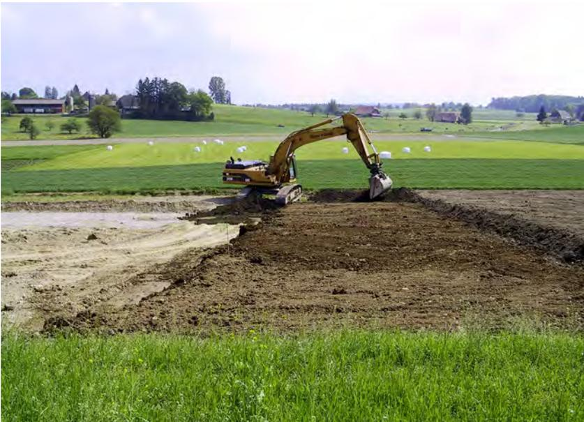
**Abbildung 8-2:** Verwertung von abgetragenen Ober- und Unterboden: Der auf dem Untergrund stehende Bagger baut Unter- und Oberboden separat im Streifenverfahren ein.
