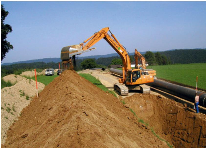
Abbildung 4–2: Korrekter Bodenaushub im Rahmen des Erdgasanleitungsbaus mit Trennung von Ober- und Unterboden
