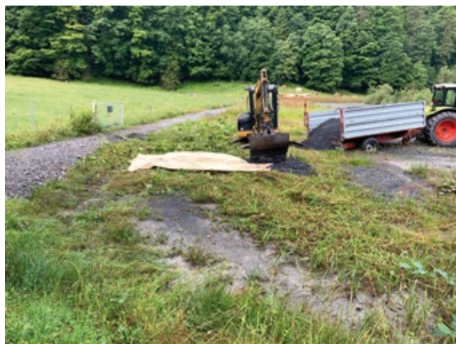
Bei dieser Bekämpfungsvariante wird der Bestand des Gestreiften Süssgrases zuerst mit Jute abgedeckt und anschliessend mit Kies überschüttet. (Foto: Ruedi Wyss)
