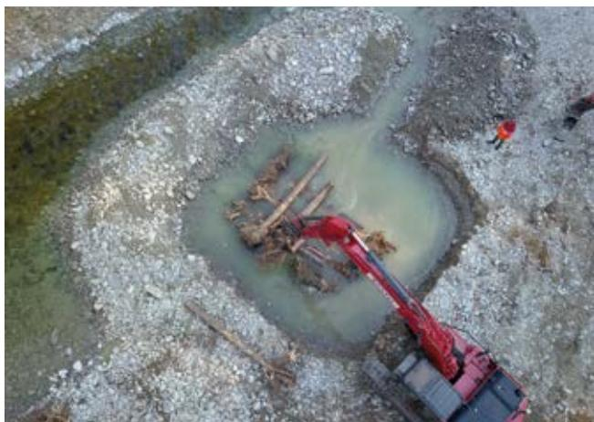
Einbau einer künstlichen Totholzverkläuserung (Engineered Log Jam) innerhalb eines Wasserhaltungsdammes (Foto: Emch+Berger AG).
