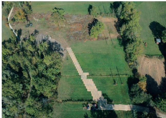
Arbeitsfortschritt am 5. Oktober 2023. Die Rodungsarbeiten sind fast abgeschlossen. Gut sichtbar die mit Druckverteilungsplatten zum Schutz von Vegetation und Boden errichtete Zufahrt. (Foto: Marc Hofmann, Hofmann Tiefbau AG)
