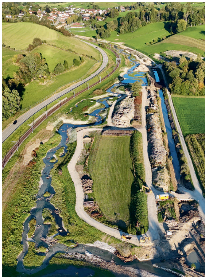
Flugaufnahme mit den neu angelegten Talmäandern der Birs im Abschnitt Court.
