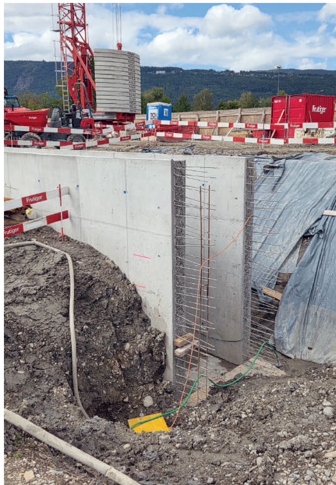
Freispiegelgerinne im Bau im Kraftwerk Brügg.
