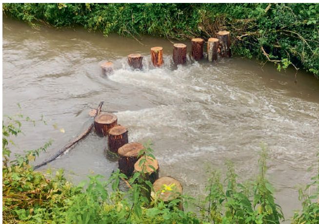
Palisadenbuhne als Strukturierungsmassnahme im Abschnitt Sorvilier. Épis en troncs comme mesure de structuration sur le tronçon de Sorvilier. Photo : Renaturierungsfonds / Fonds de régénération des eaux
