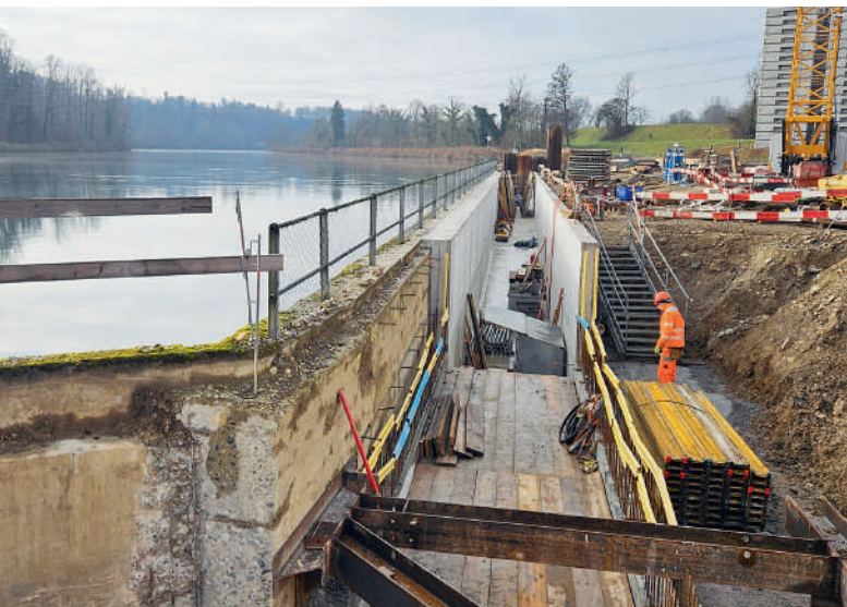
Fischaufstieg im Bau im Kraftwerk Wynau Schwarzhäusern.
