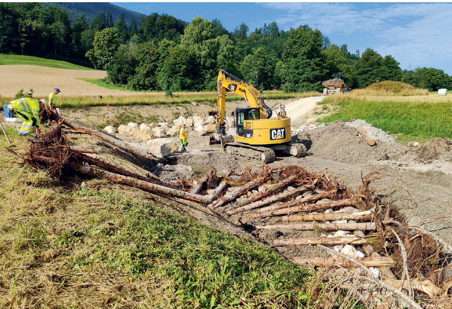
Ingenieurblogische Verbauung einer Aussenkurve mit Baumstämmen und Wurzelstöcken im Abschnitt Sorvilier. Aménagement en matières naturelles d'un virage extérieur avec troncs d'arbres et souches sur le tronçon de Sorvilier. Photo : Renaturierungsfonds / Fonds de régénération des eaux
