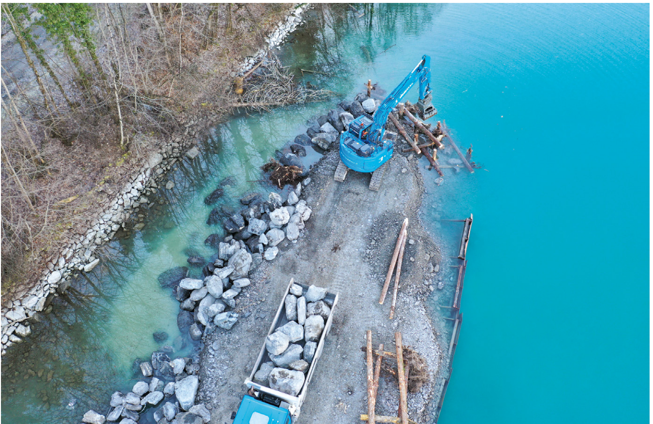
Revitalisierung Seeufer Brienzersee: Bau von Inseln und Flachufern.
