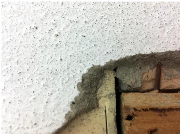
**Enduits:** Prélever un échantillon de la taille d'une pièce de 5 francs au moins, avec toutes les couches jusqu'au mur porteur. Recouvrir ensuite le point de prélèvement avec du ruban adhésif.
