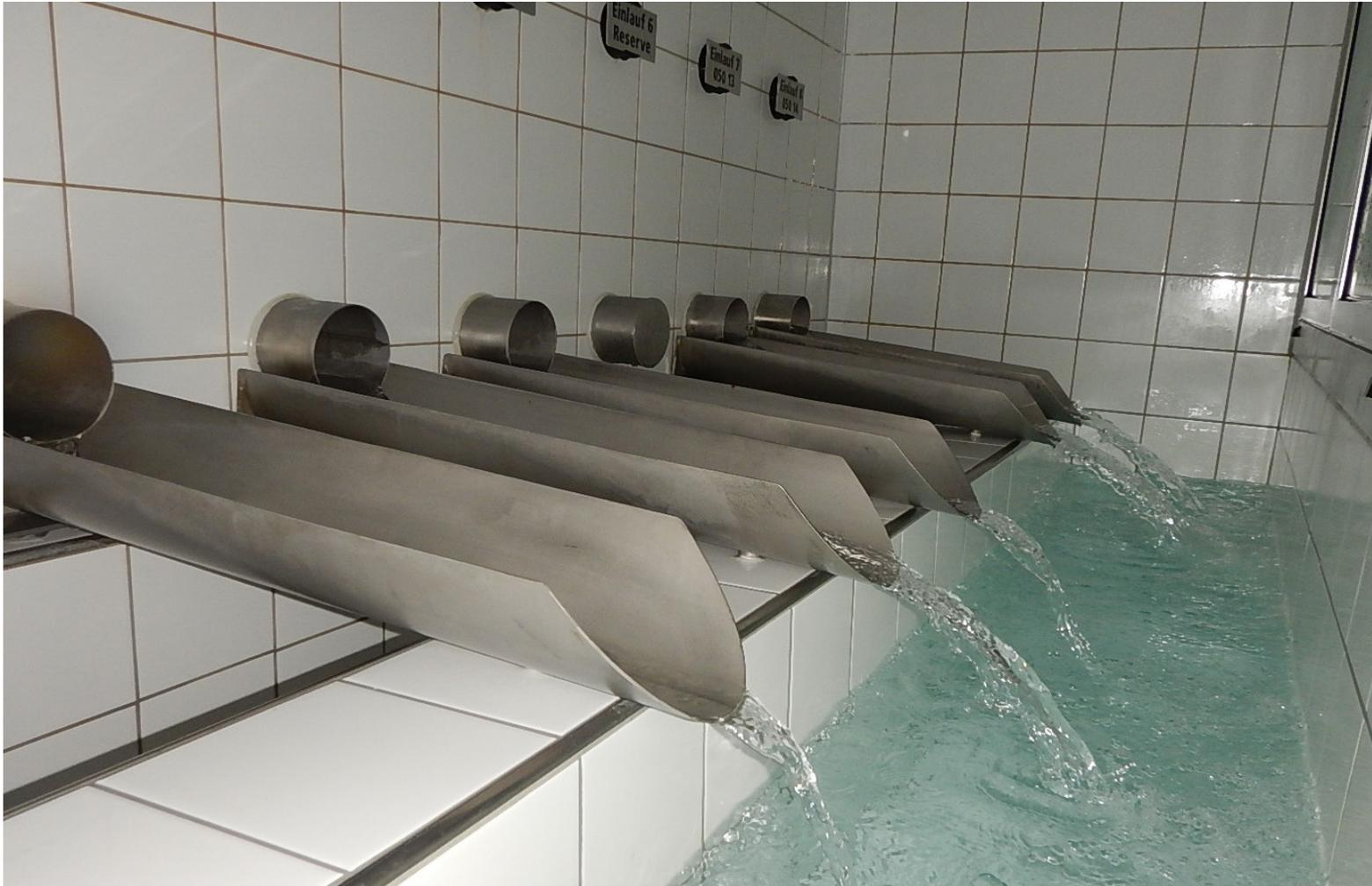
Abb. 13 Einlaufkammer eines Trinkwasser-Reservoirs einer öffentlichen Wasserversorgung.
