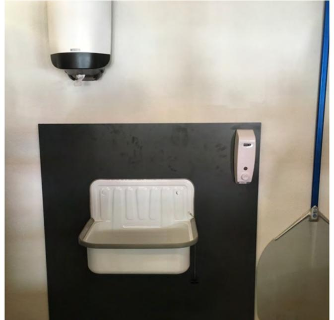
Abb. 18 Handwaschgelegenheit in einer Pizzeria, ausgerüstet mit Seifenspender und Papierhandtuchspender, aber ohne Wasseranschluss.
