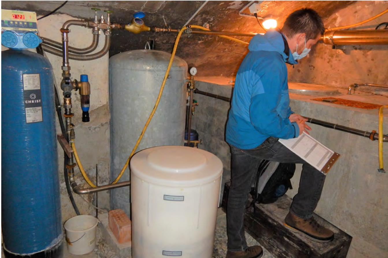
Abb. 19 Technischer Inspektor bei der Kontrolle der Wasseraufbereitungsanlage einer Kleinst-Wasserversorgung.
