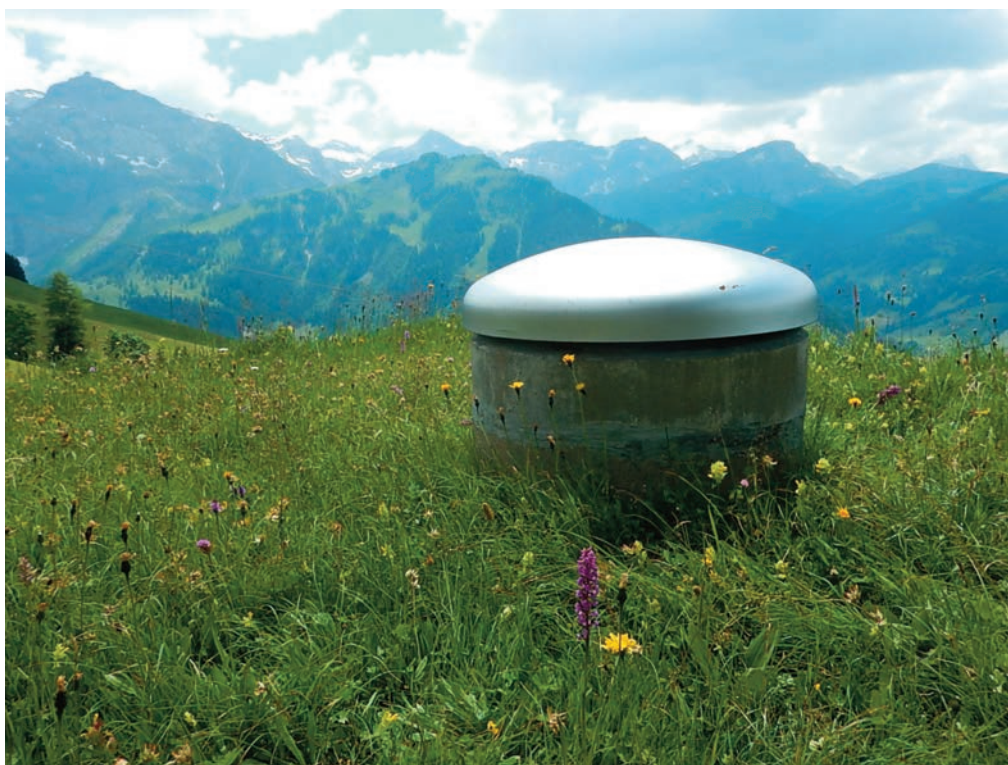
Abb. 24 Mit einer vorbildlichen Überhöhung gegenüber dem Gelände und einem gut schliessenden Deckel ist diese Brunnstube gut vor Verunreinigungen geschützt.
