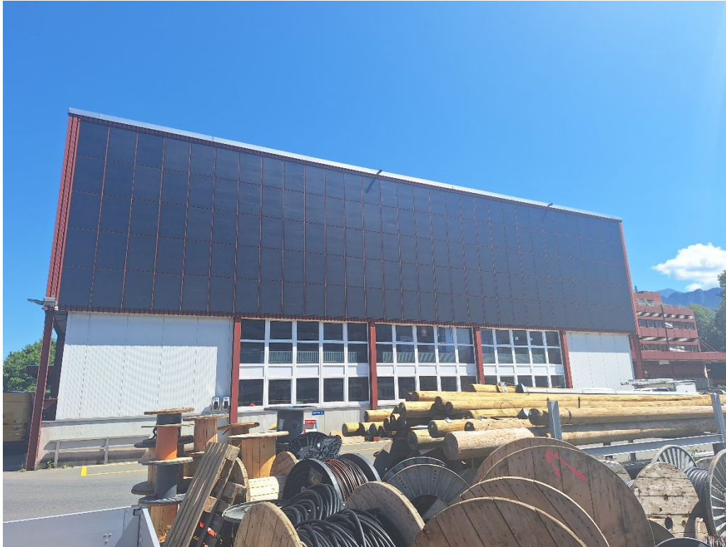
Abbildung 10: Leichtgewichtsmodul ohne Unterkonstruktion, welches direkt auf die Fassade geschraubt wird.
