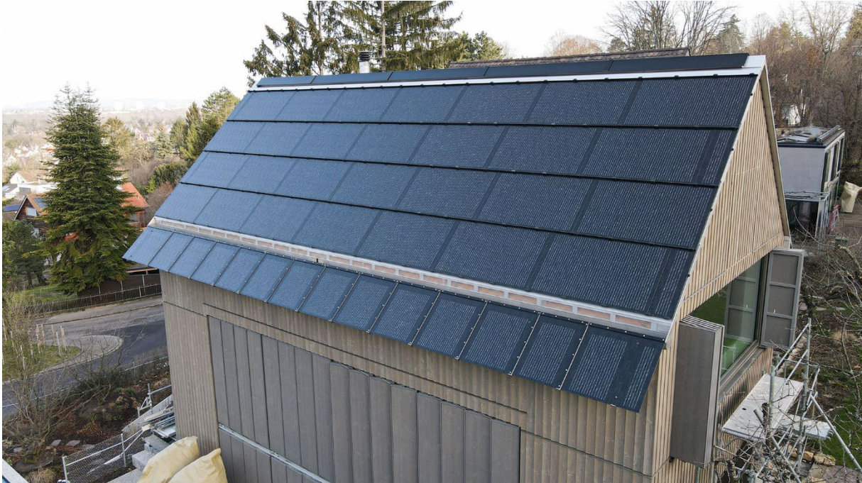
Abbildung 14: Einfamilienhaus mit strukturierten Solarmodulen (Megasol, 2019).
