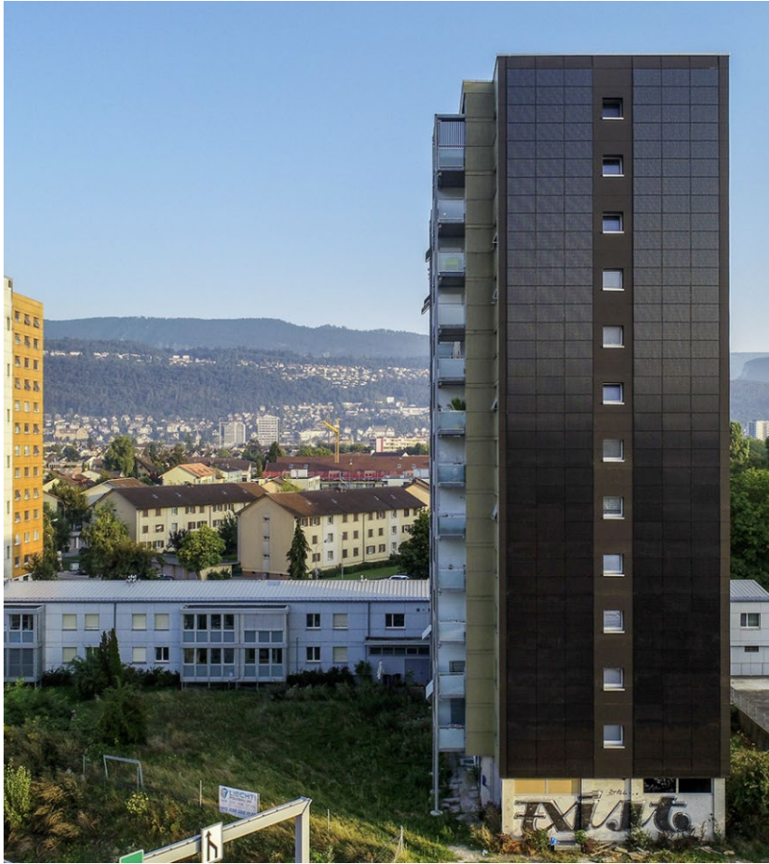
Abbildung 2: Hinterlüftete Fassadenmodule in Biel (Swiss Solar Solutions, 2022).
