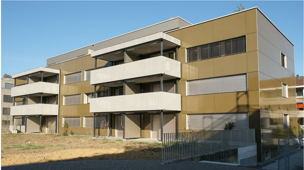
Abbildung 12: Wohnsiedlung mit PV-Fassade in Retro-Bronze (Megasol, 2020).
