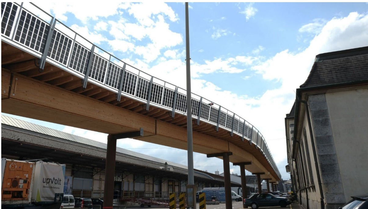
Abbildung 7: PV-Geländer eines Fahrradwegs in Basel (Megasol, 2023b).
