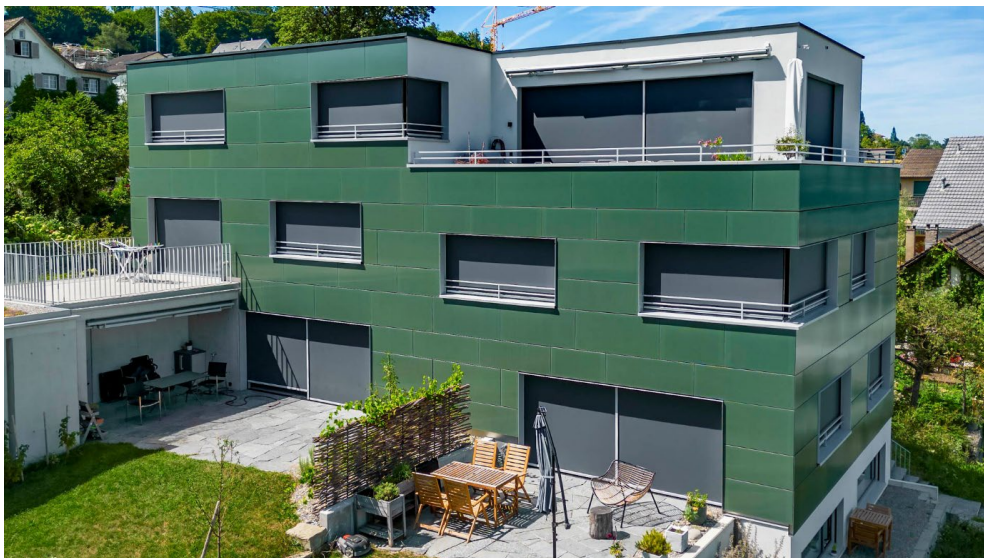
Abbildung 3: Vorgehängte Fassadenmodule an einem Mehrfamilienhaus (Megasol, 2023a).
