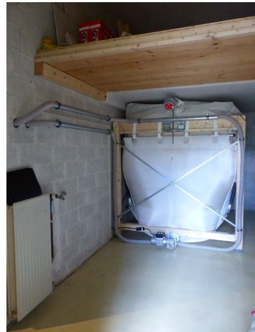
Silo textile étanche au fond du garage (préfabriqué)
