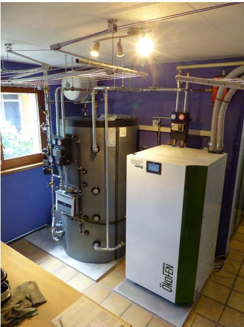
Accumulateur combiné pour solaire et chaudière
