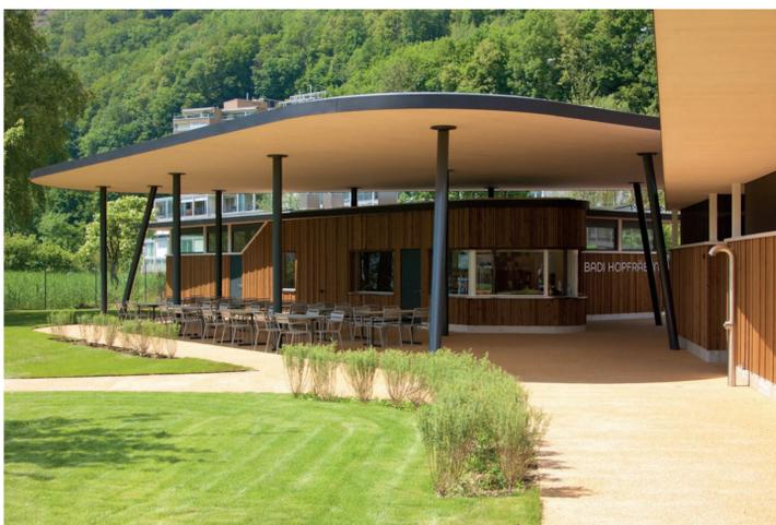
Die Technologie von TS3 ermöglicht Skelettbaustrukturen aus punktgestützten Flachdecken in Holz, wie sie bis anhin nur von Stahlbetonkonstruktionen bekannt waren. Heute ist das in Holz möglich, was lange konstruktiv undenkbar schien: Brettsperrholzplatten werden stirnseitig mit einem biegesteifen Gusscharz verbunden.
