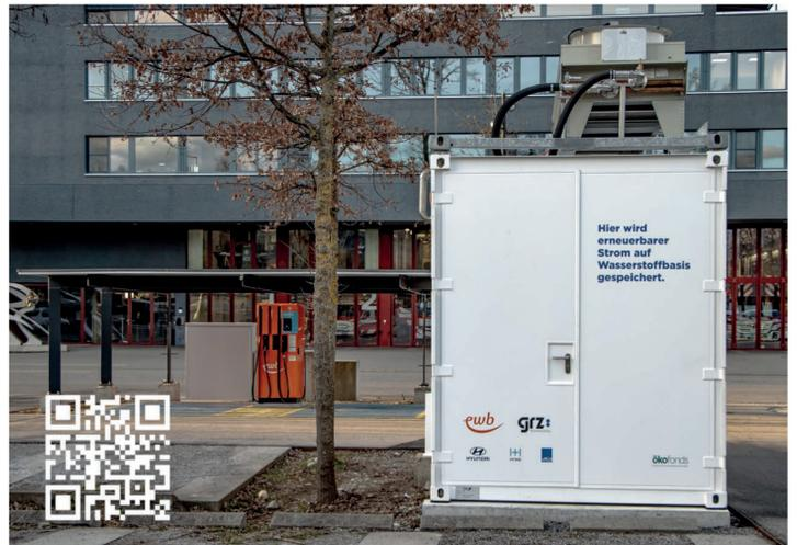
Alternativ zur Rückverstromung lässt sich der in den Metallhydriden gespeicherte Wasserstoff aber auch direkt in den Tank eines Fahrzeuges ausgeben, in einem eleganten Verdichtungsverfahren ohne die Notwendigkeit für bewegliche Teile. Damit sind hohe Wartungskosten kein Hindernis zur Wasserstoffmobilität mehr und dank der hohen Zuverlässigkeit eignet sich diese Anlagen insbesondere auch für den anspruchsvollen landwirtschaftlichen Bereich.
